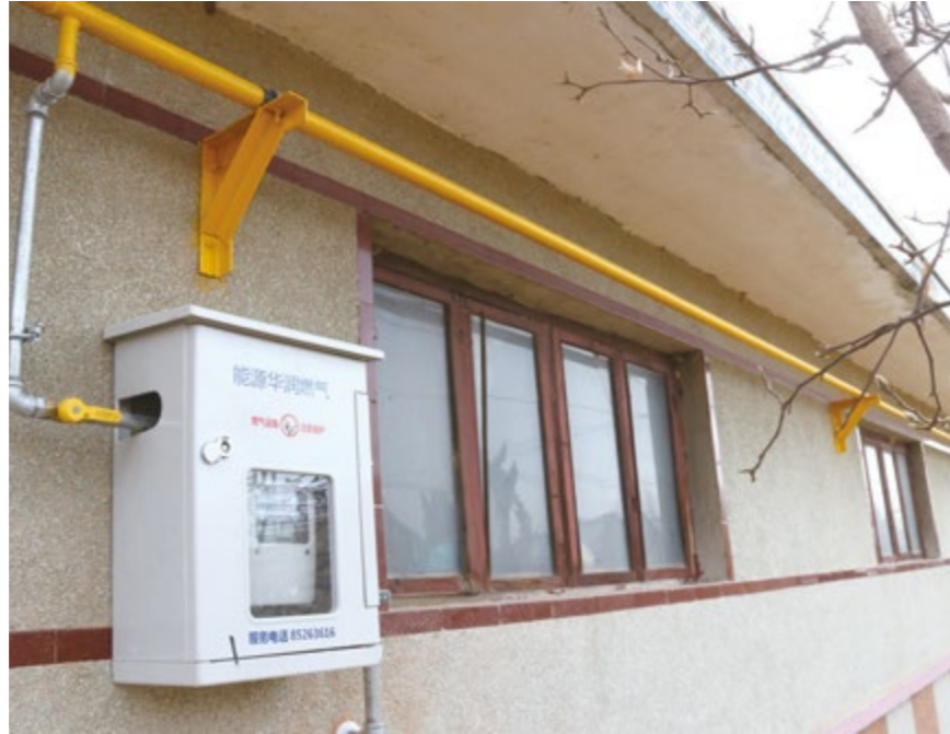
胶州公司全力打造美丽乡村“气代煤”项目样板，帮助村民实现清洁取暖，改善乡村空气质量
