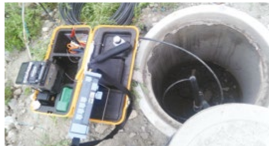
光纤熔接测试
