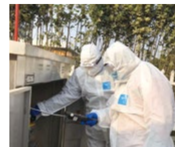
淄博公司开展燃气管道巡检
